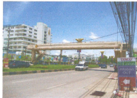
รูปที่ ๒. สะพานลอยที่โรงพยาบาลพลฯ
